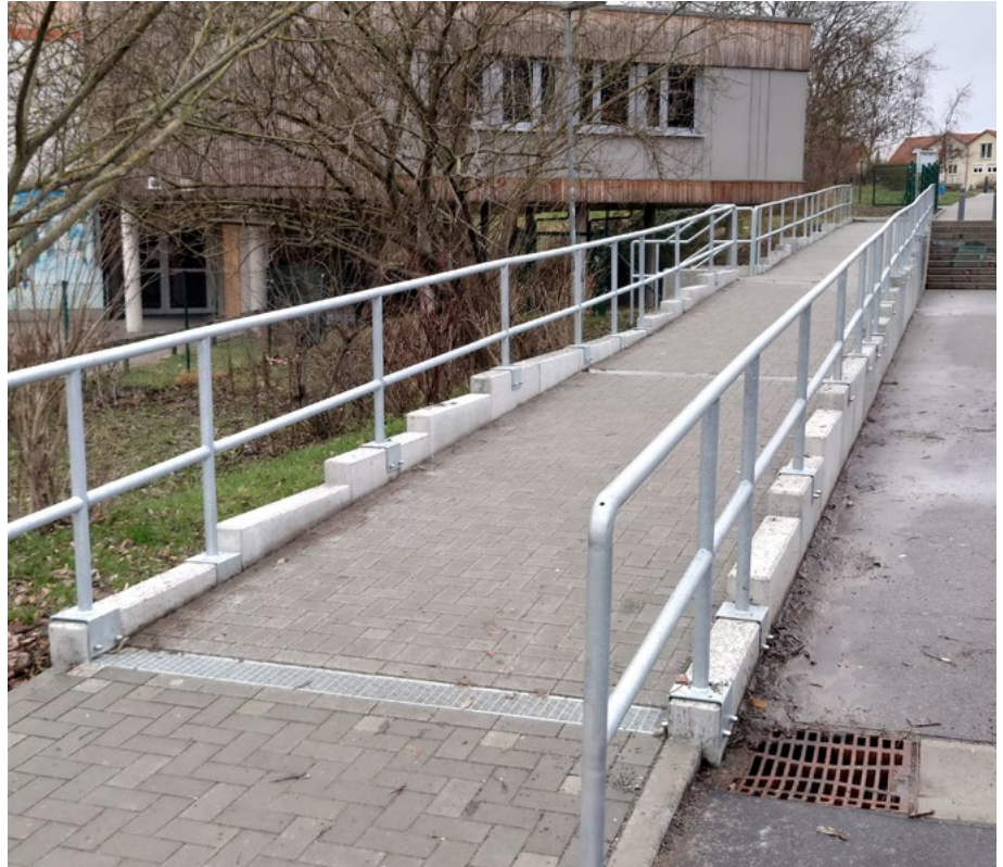
Trotz Störmanövern endlich fertiggestellt und begehbar: Die Rampe zwischen Michael-Bittner-Platz und Bürgerpark.
